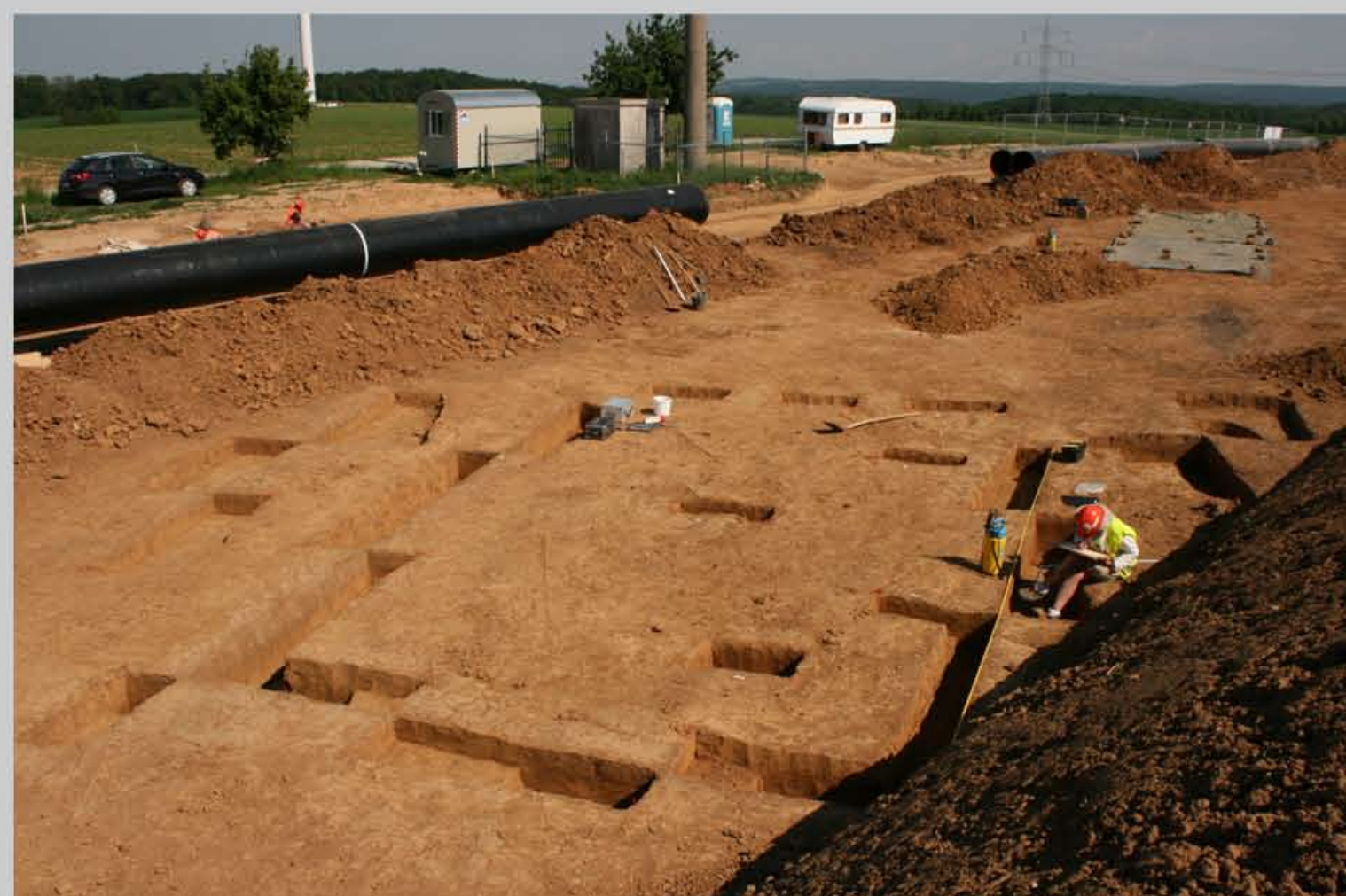
Baubetrieb und Archäologie auf der Esbachhöhe - beides verlief parallel und musste entsprechend koordiniert werden.
